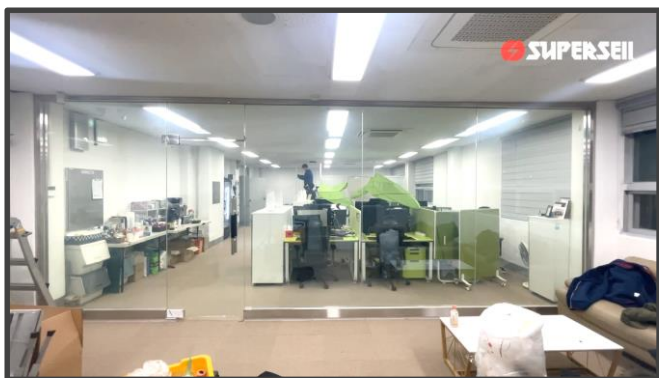
셀뷰어 PDLC 필름 유리가벽 (ON 상태)
